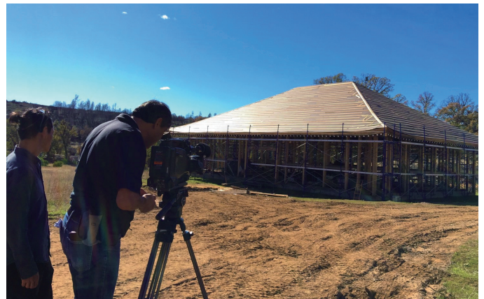
天平山禅堂建設現場での撮影
