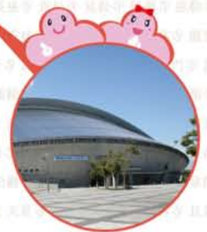
「グランディ・21」 宮城県総合運動公園総合体育館
