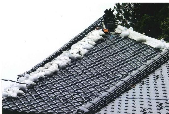
地震で崩落したままの参道。本堂屋根も未修理であり、シートと土嚢で応急処置のみの対応である。(撮影日不明)
