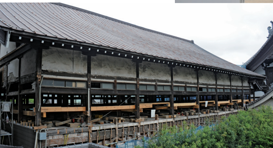
天真閣改修工事
