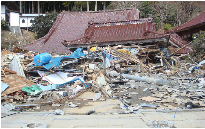
津波によって倒壊した本堂と山門
