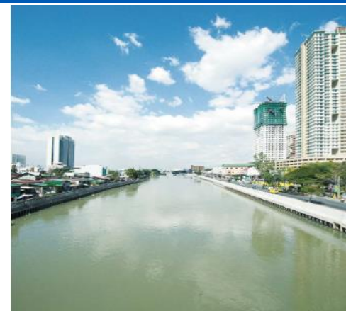
（事例）フィリピン「パッシング・マリキナ川河川改修事業」： マニラ首都圏中心部を貫流するパッシング・マリキナ川流域における洪水対策計画の策定及びその実施、ハザードマップ作成等
