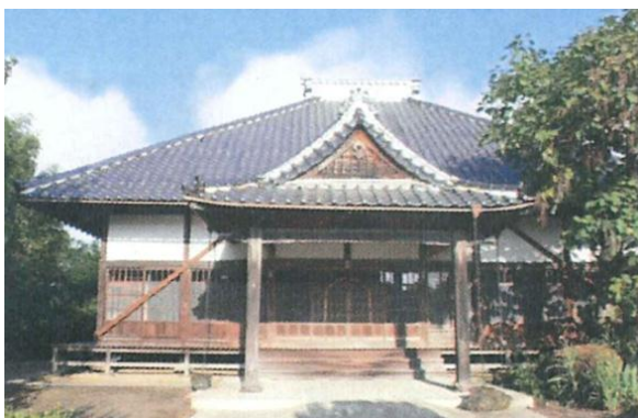
本堂の内外には筋交が取り付けられている。山門の土台修理や庫裡の2階部分をトタン屋根にする等、様々な改修が必要となった。(撮影日不明)
