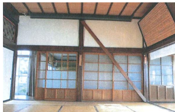
本堂の内外には筋交が取り付けられている。山門の土台修理や庫裡の2階部分をトタン屋根にする等、様々な改修が必要となった。(撮影日不明)
