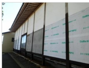
本堂内部の壁は崩落したままである。外部の壁は、コンクリートパネルを貼って応急処置をしている。庫裡玄関前等のコンクリート部分は、亀裂が入ったままである。(撮影日 H25.9.27)
