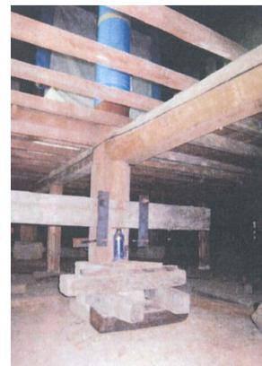
左の写真は28mm沈下した毘沙門堂。本堂同様に、ジャッキをかけて慎重に高さを揃えていく。中の写真は本堂の不陸調整の様子。慎重な作業が必要であった。(撮影 H24. 9. 14)
