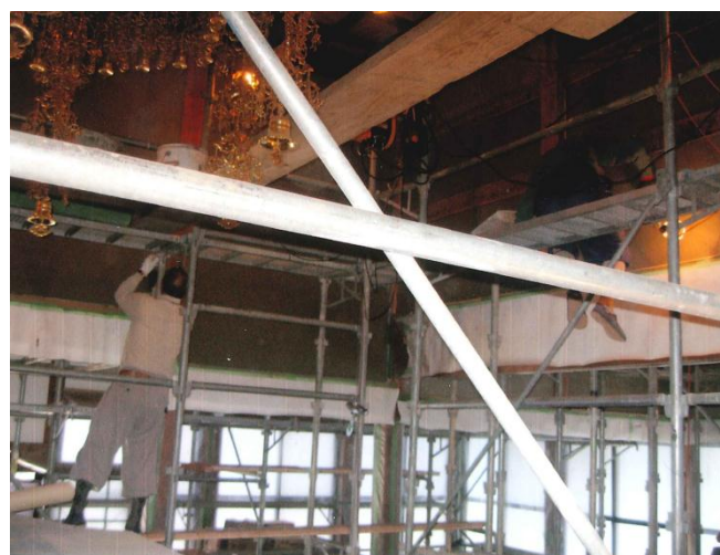
本堂の内外に足場を組み、外壁や漆喰の塗壁工事等の改修工事に取り組んでいる。(撮影日不明)
