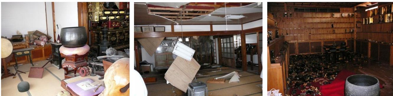
震災後のままだの本堂では、仏像が倒れ什器が散乱し、天井が落ちて、雨漏りのため一部の畳は腐っている。位牌堂の被害も大きく、位牌は倒れ落ちたままの状態である。龍台寺の所在する富岡町は帰宅困難区域となっており、放射能汚染被害により手を付けることもできない。(撮影日 H25. 9. 26)
