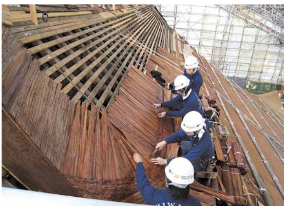
図3 選定保存技術 檜皮葺・柿葺 (檜皮葺施工中の状況)
