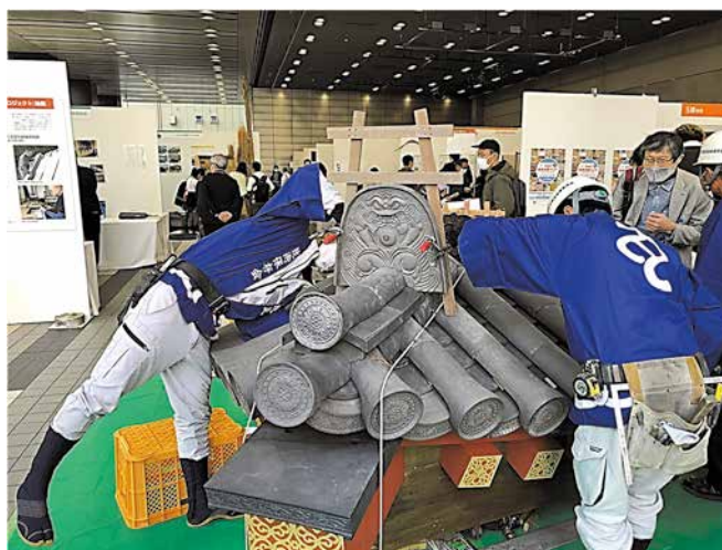
図4 選定保存技術 屋根瓦葺（本瓦葺） （令和 3 年「日本の技フェア」にて）
