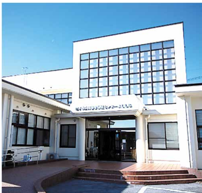
図1 障害者福祉センターふじしろ
